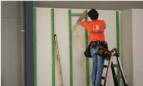
Schlagen Sie die Schlagdübel mit einem Hammer in die gebohrten Wandlöcher ein, um so die vertikale Latte an der Wand befestigen zu können.
